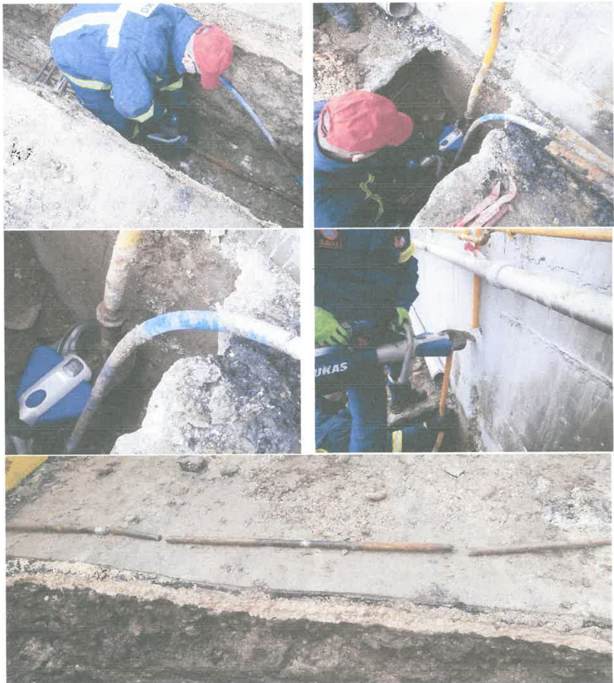
Εικόνα 3: Αυτοψία στον αέριο χώρο του εργοστασίου «ΒΙΟΛΑΝΤΑ Α.Ε.». Δειγματοληψία μέσω αποκοπής τμήματος της σωλήνωσης με μέθοδο αδιατάρακτης κοπής
