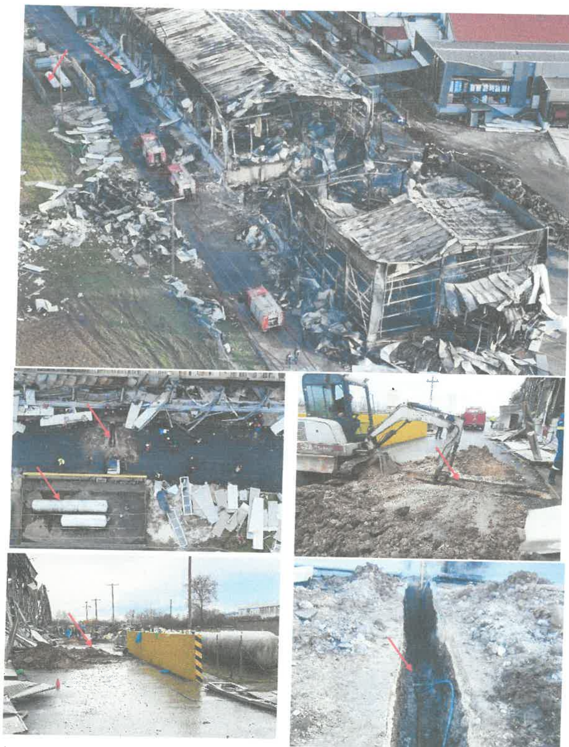
Εικόνα 1: Αυτοψία στον αύλειο χώρο του εργοστασίου «ΒΙΟΛΑΝΤΑ Α.Ε.». Διακρίνονται οι δεξαμενές προπανίου, και η εκσκαφή-αποκάλυψη τμήματος υπόγειας σωλήνωσης
